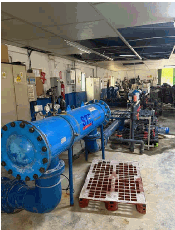
Exterior.Cabezal de Riego
