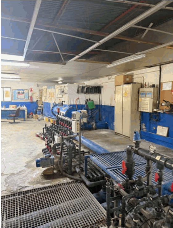
Exterior.Cabezal de Riego
